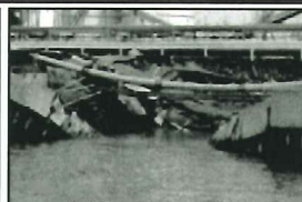
液状化による護岸の被災
