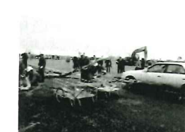
近畿地整職員による道路啓開
