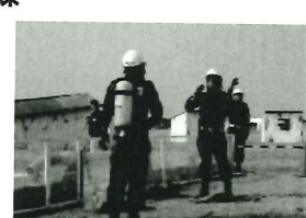
大阪ガスが切損したガス管の復旧
