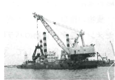
姫路港（-12m航路・泊地浚渫）
