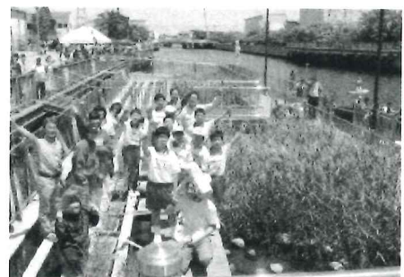
北堀運河の水質浄化施設
