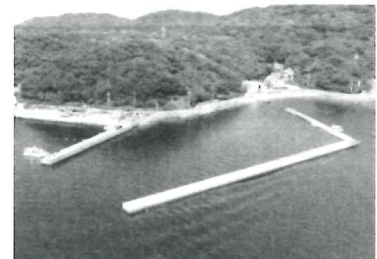
家島港網手地区（防波堤）
