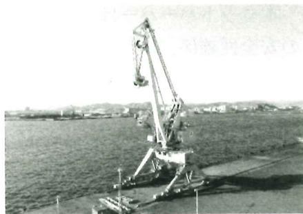
更新予定のクレーン（姫路港）
